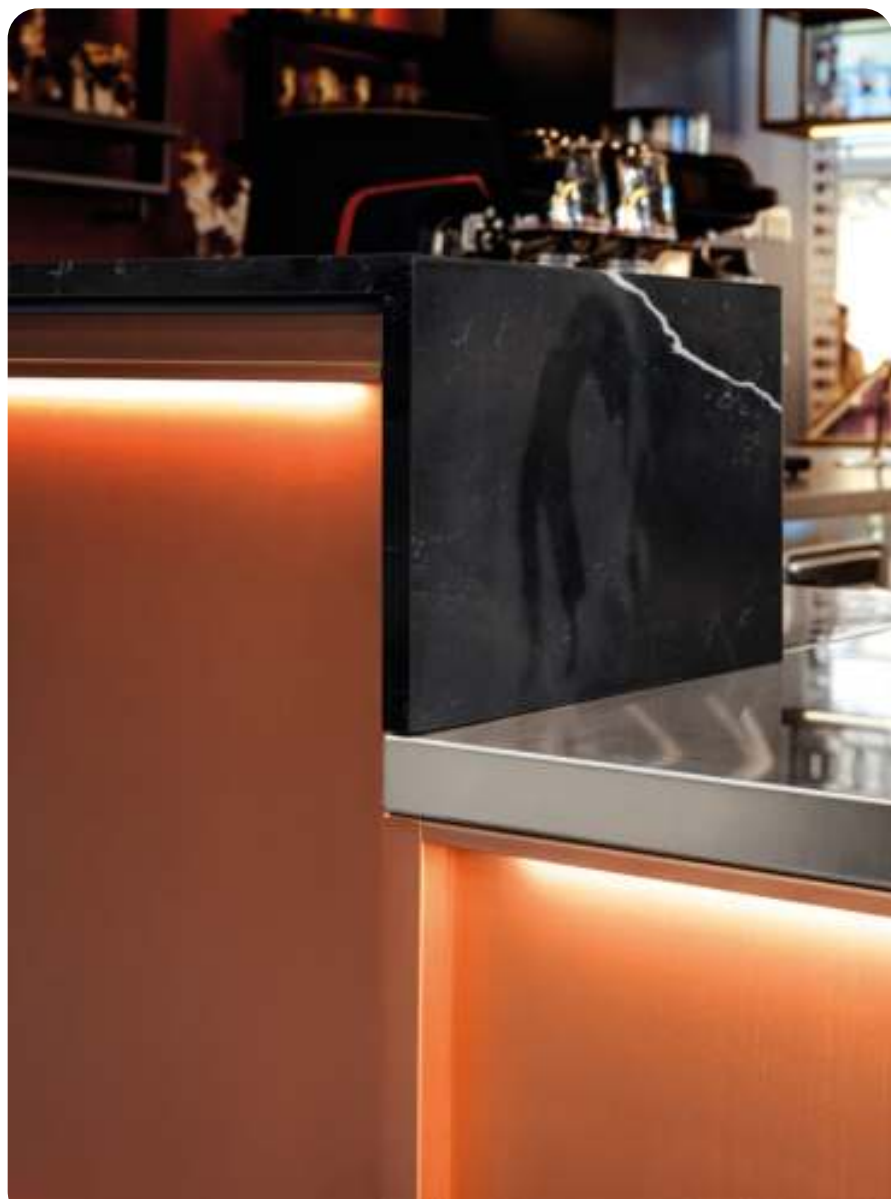
Particolare del raccordo tra la bancalina superiore in gres del banco mescita (H 1200 mm) con il banco di servizio (H 960 mm) con piano in acciaio inox.
